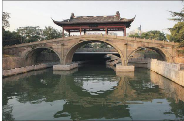
杭州坝子桥外貌
