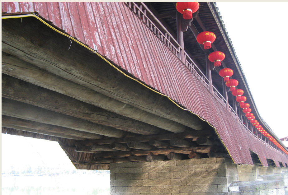
图6 永康西津桥伸臂梁结构
