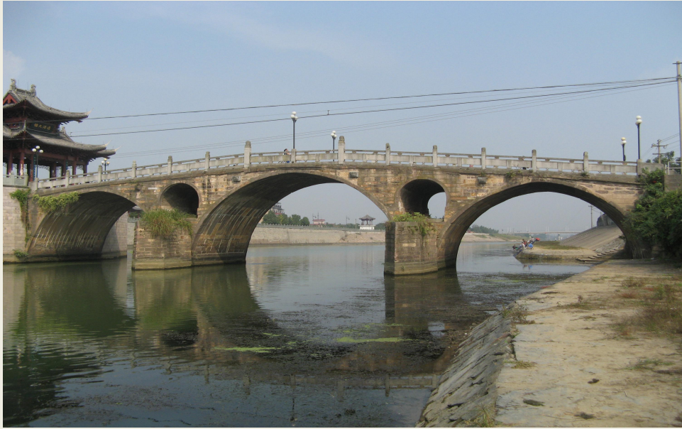
图 22 杭州余杭通济桥
