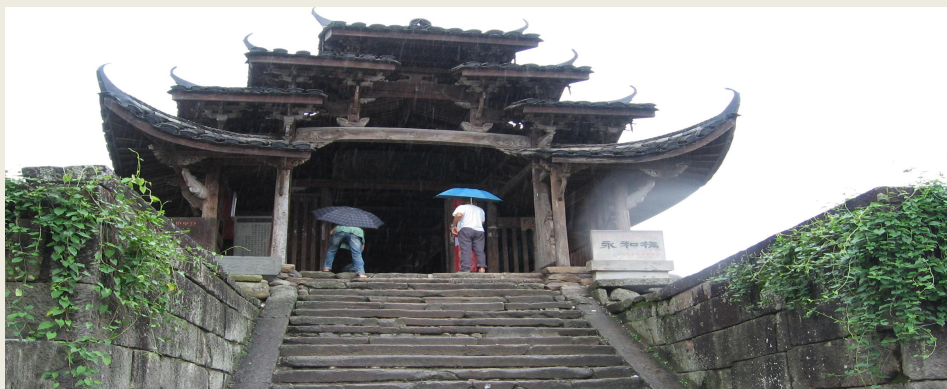
图 32 永和龙泉桥桥门
