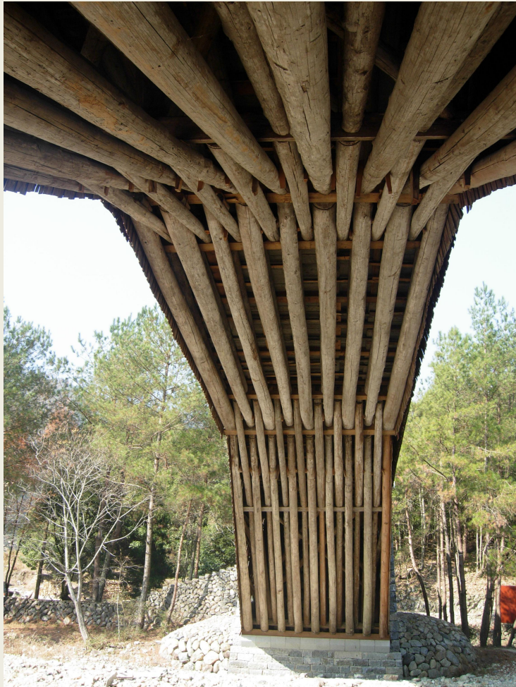
图 13 庆元兰溪桥贯木拱结构
