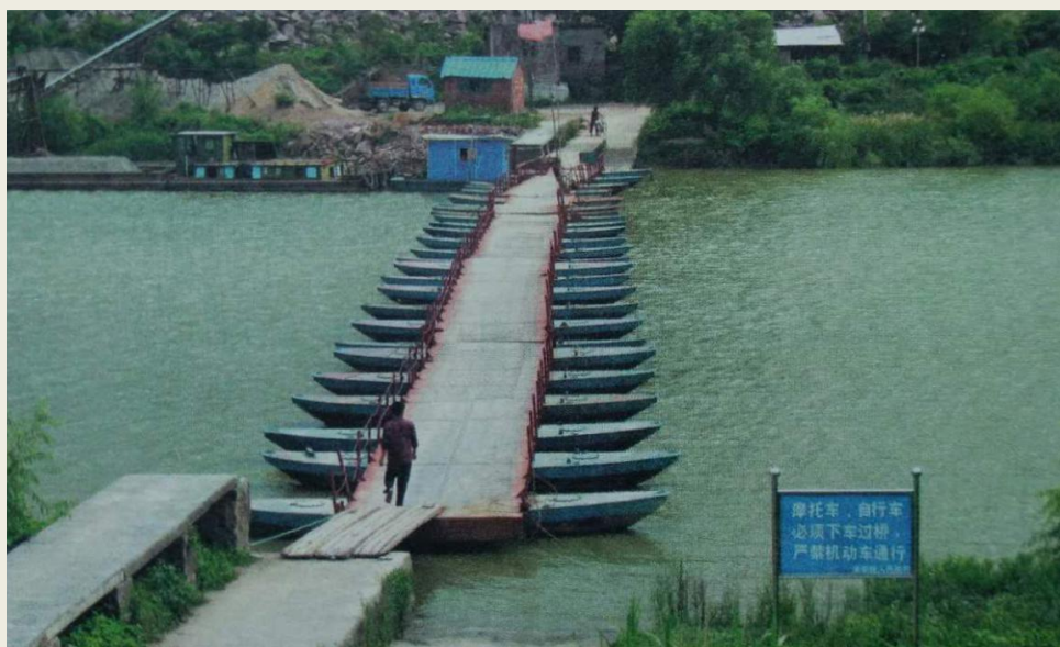
图 24 杭州萧山浮桥
