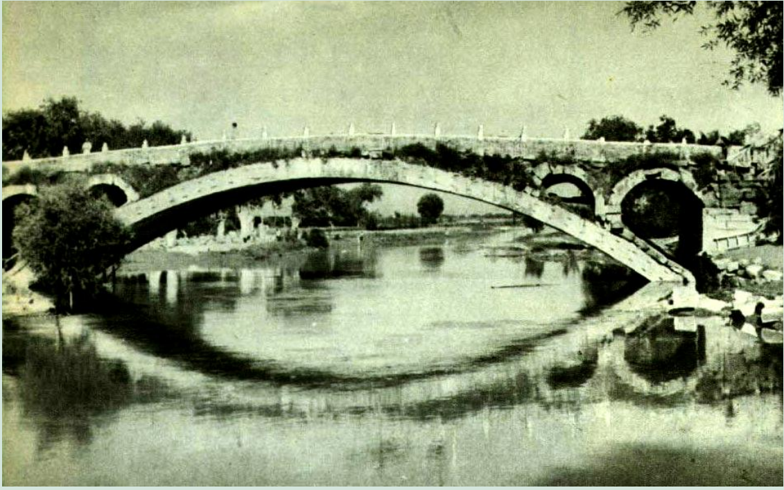
图 15 1954 年维修前的桥梁
