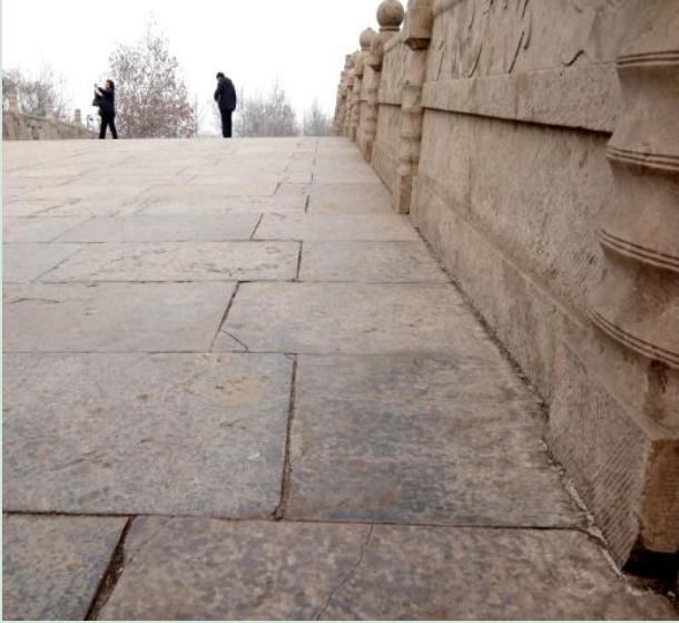
图 17 桥面护栏的立柱与石板之间的拼接缝增大
