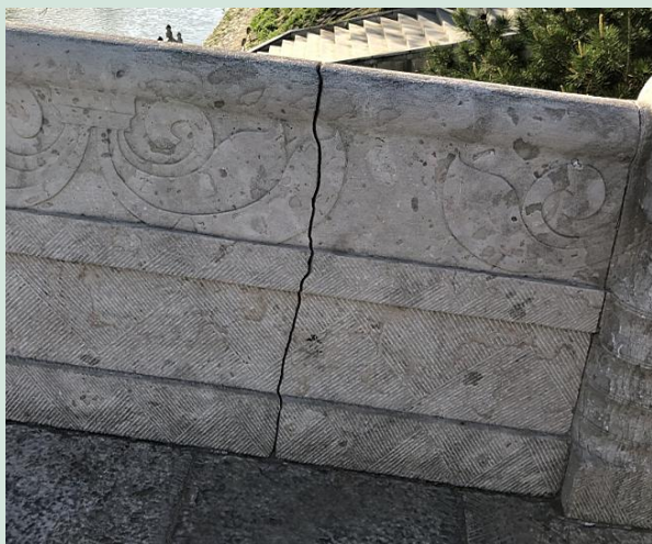
图 18 桥面石板少数开裂、桥面护栏局部轻微外倾、少数护栏石板上缘受拉开裂
