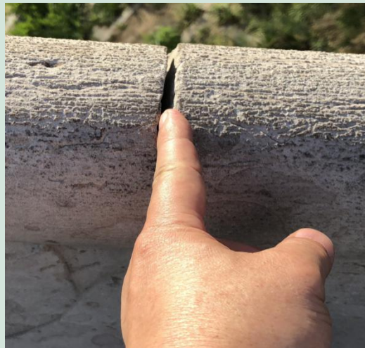
图 18 桥面石板少数开裂、桥面护栏局部轻微外倾、少数护栏石板上缘受拉开裂
