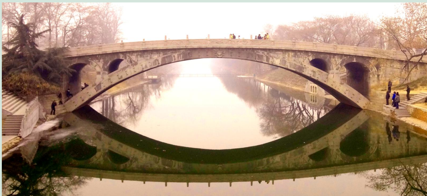
图 1 公元 605 年建成跨度 37.02m 的赵州桥
