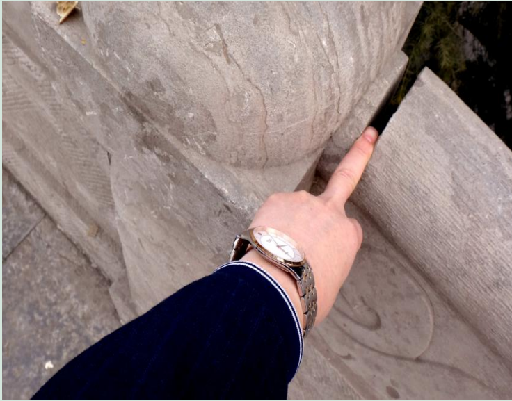
图 17 桥面护栏的立柱与石板之间的拼接缝增大
