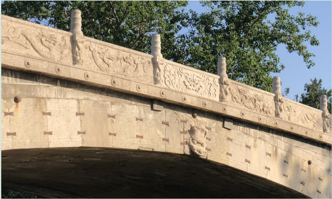
图 10 主拱圈顶部的“龙头”和桥面护栏外侧浮雕
