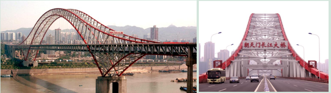
图 24 552m 跨度的重庆朝天门长江大桥
