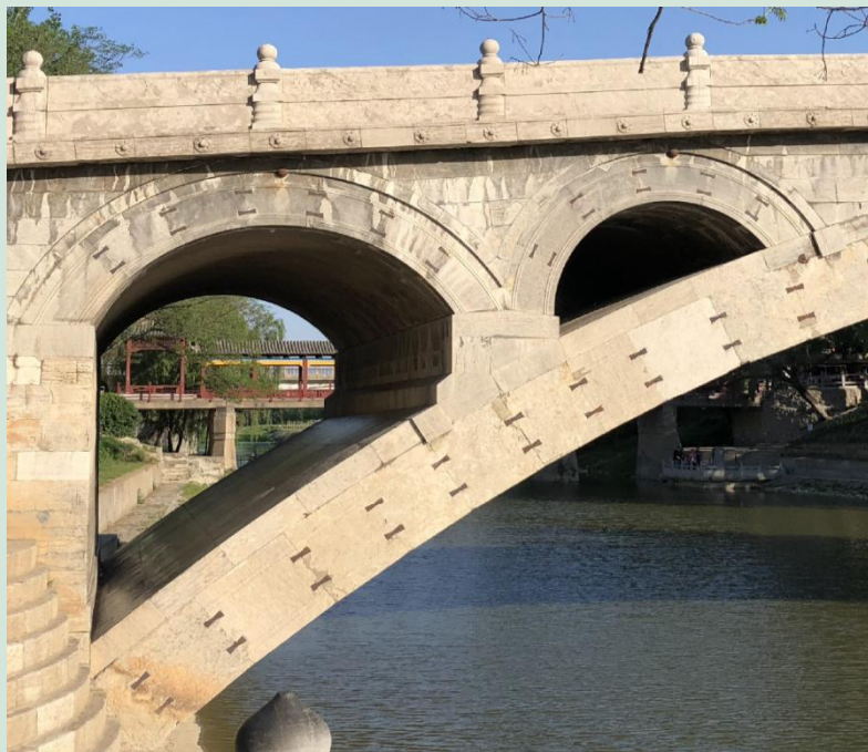
图9 主拱圈和小拱圈连接细部
