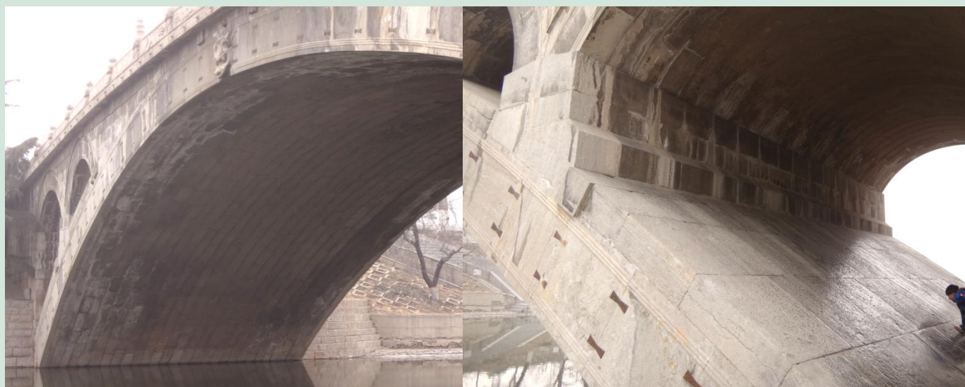
图 5 下层拱圈 28 条拱券并列布置，上层拱圈(含 6 条钩石)及小拱支墩块石错列布置
