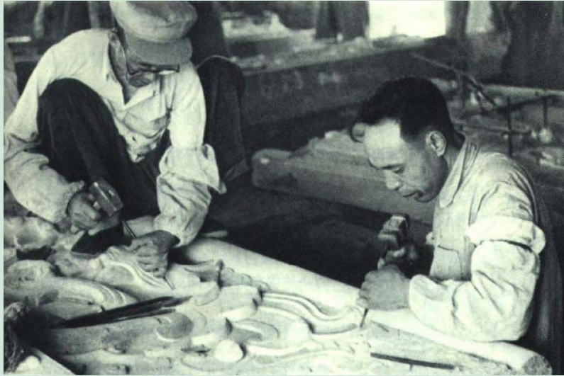
图 16 重新雕刻制作部分护栏
