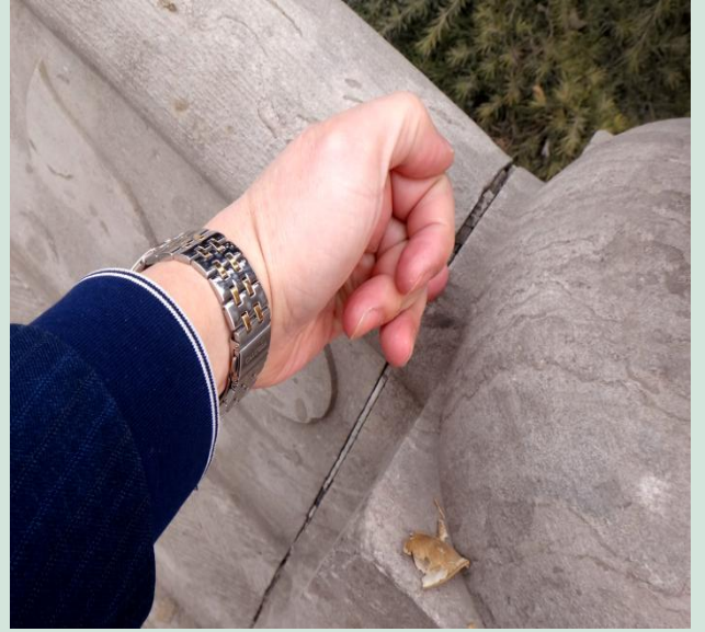
图 17 桥面护栏的立柱与石板之间的拼接缝增大
