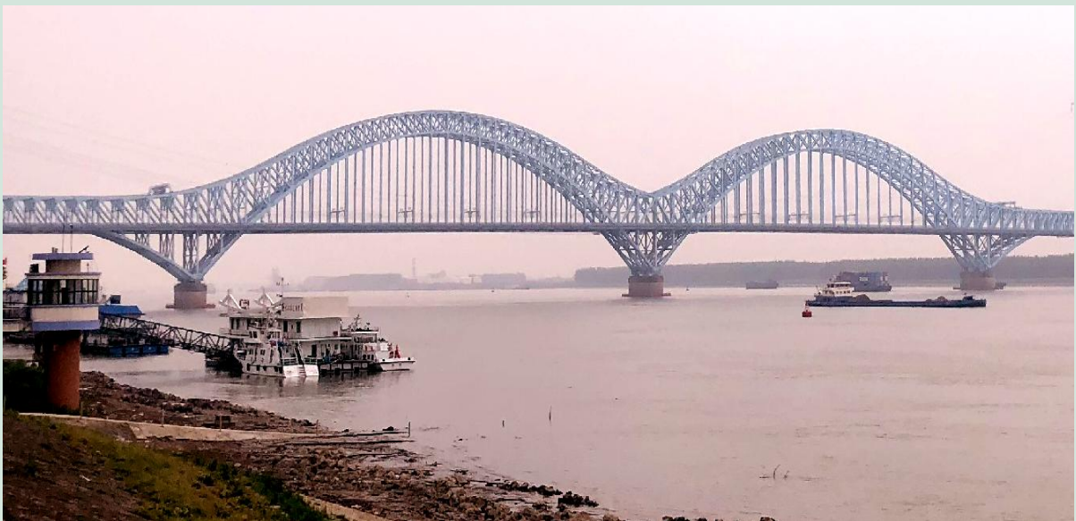
图 25 两主跨 336m 的南京大胜关长江大桥
