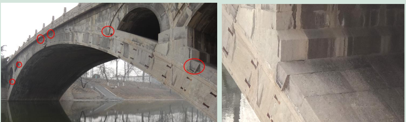
图7 上层拱圈设置6道长条状钩石(圆圈内)
