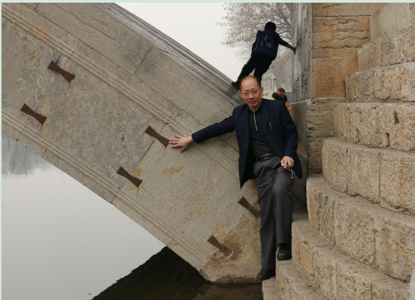
图 4 拱脚附近的主拱圈
