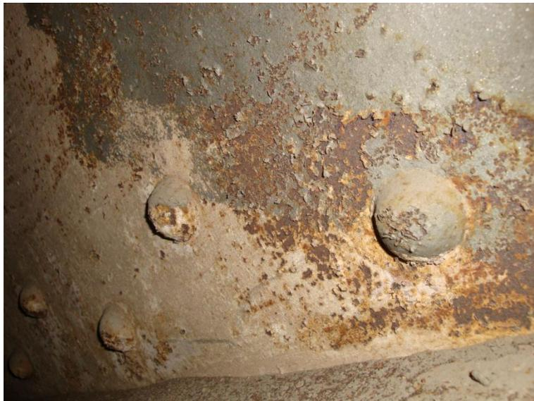
4) 托架焊缝和锈蚀
