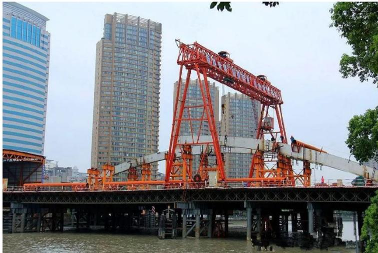
为兼顾灵桥的交通功能与文物价值，在本次大修工程中，建设单位既对灵桥结构进行了维修加固，又最大限度地维护了其文物价值，这使得维修的复杂性和困难性都大大超过了预期，远非普通新建工程可比。
