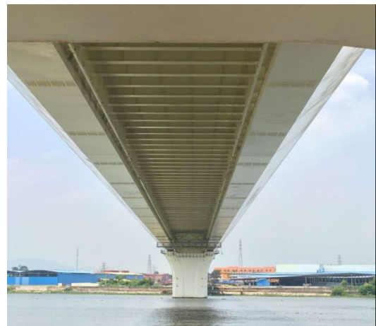
钢箱节段高强螺栓连接
